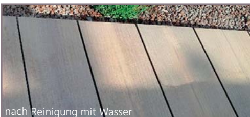
nach Reinigung mit Wasser
